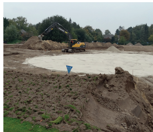
Werk in uitvoering: Overbrug wordt minder compact en uitdagender.
